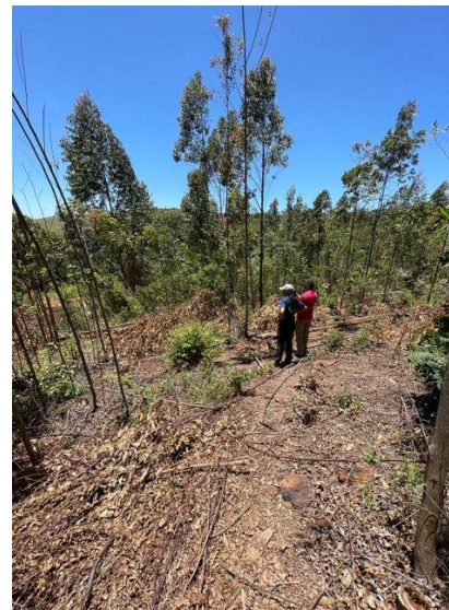
Área com supressão em andamento para comparação.
