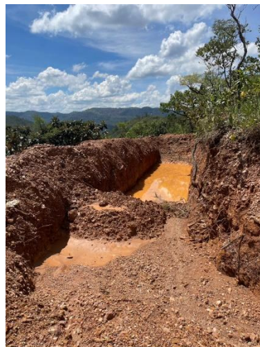
Segundo terraço escavado no terreno do senhor Antônio
