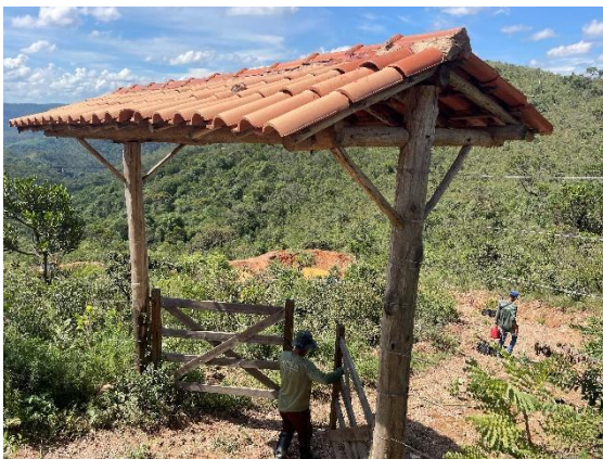
Área das barraginhas em manutenção.
