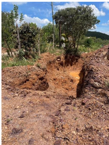
Primeiro terraço escavado no terreno do senhor Antônio.
