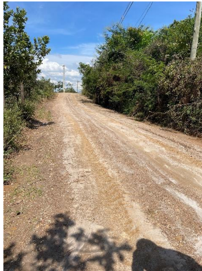
Estrada preparada com escoamento estratégico.
